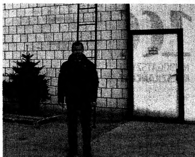
W tym budynku znajduje się chłodnia z kontrolowaną atmosferą. Owoce przechowywane w chłodni długo zachowują świeżość.
